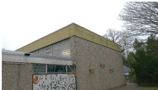
Blick auf den Bereich der Attika der Sporthalle: unterhalb der gelben Verkleidungen sind Spaltenräume vorhanden
